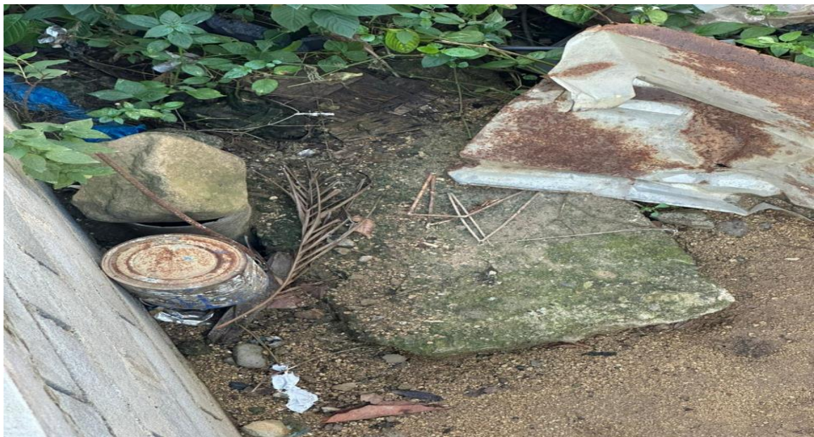
Foto 10. Pozo de abastecimiento
