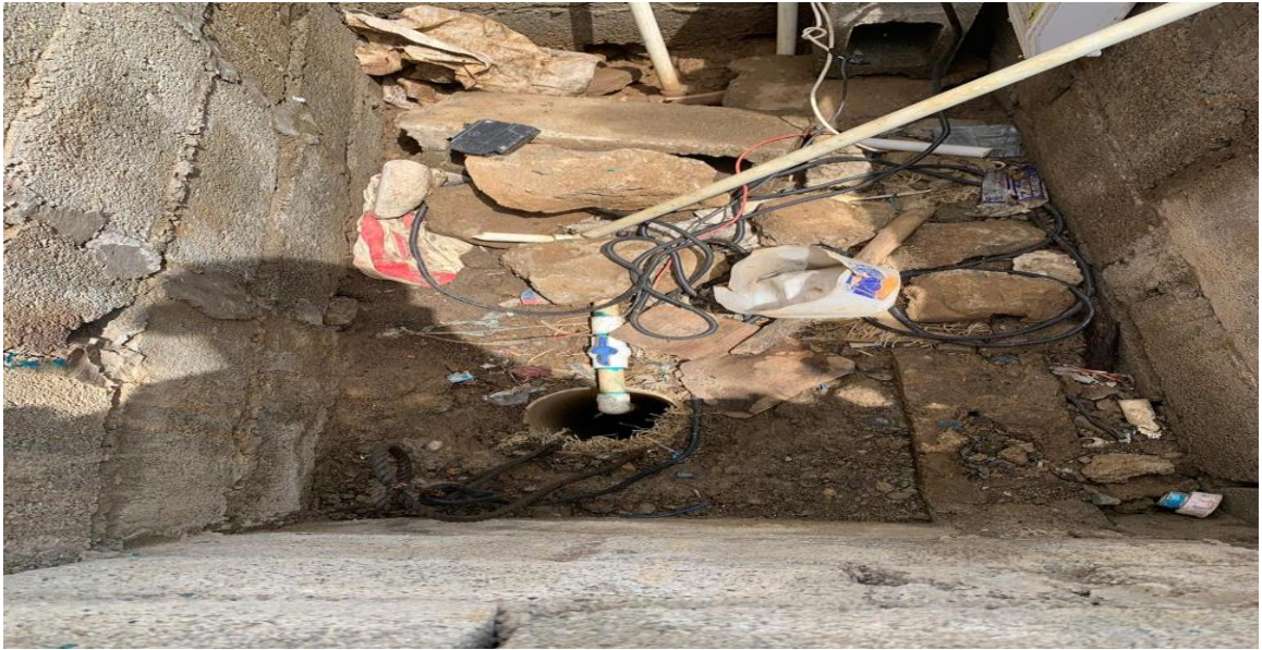
Foto 7: Pozo de abastecimiento.
