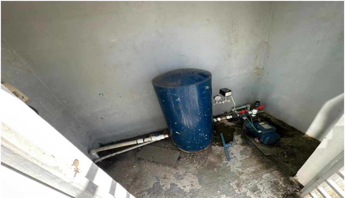
Foto 6: Pozo de abastecimiento.
