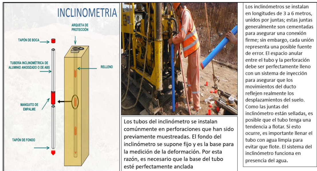
Figura 11: Proceso de instalación de inclinómetro
