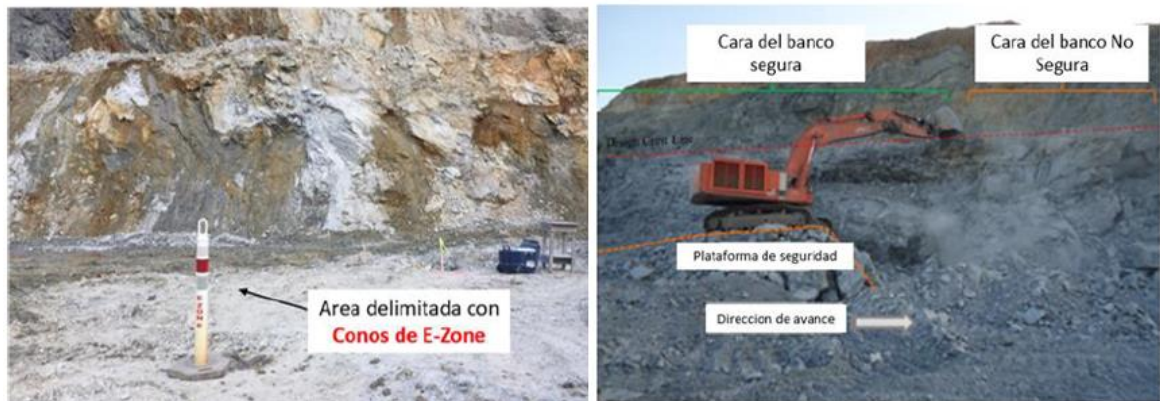
Figura 23: Delimitación de condición peligrosa y Limpieza de la cara del banco utilizando una retroexcavadora con una zanja de protección contra caída de rocas.
