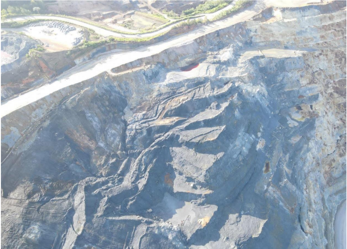
Figura 27: Falla geotécnica de múltiples bancos.
