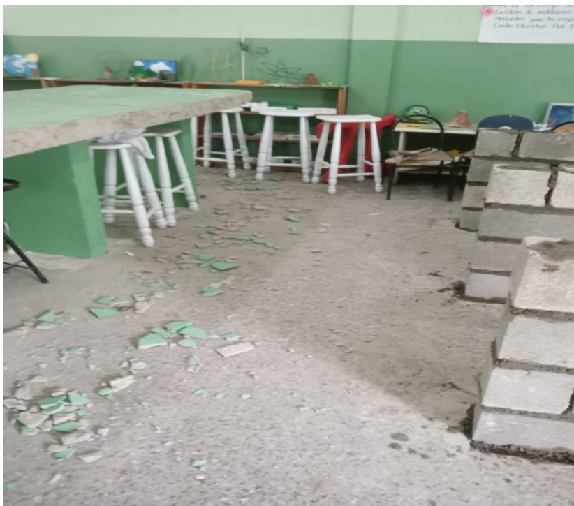
Espacio del Laboratorio antes de la ejecución del proyecto
