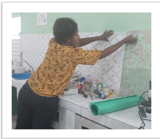
Remoción de las losetas huecas y dañadas
