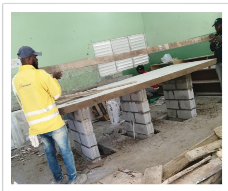
Meseta de laboratorio en proceso de construcción
