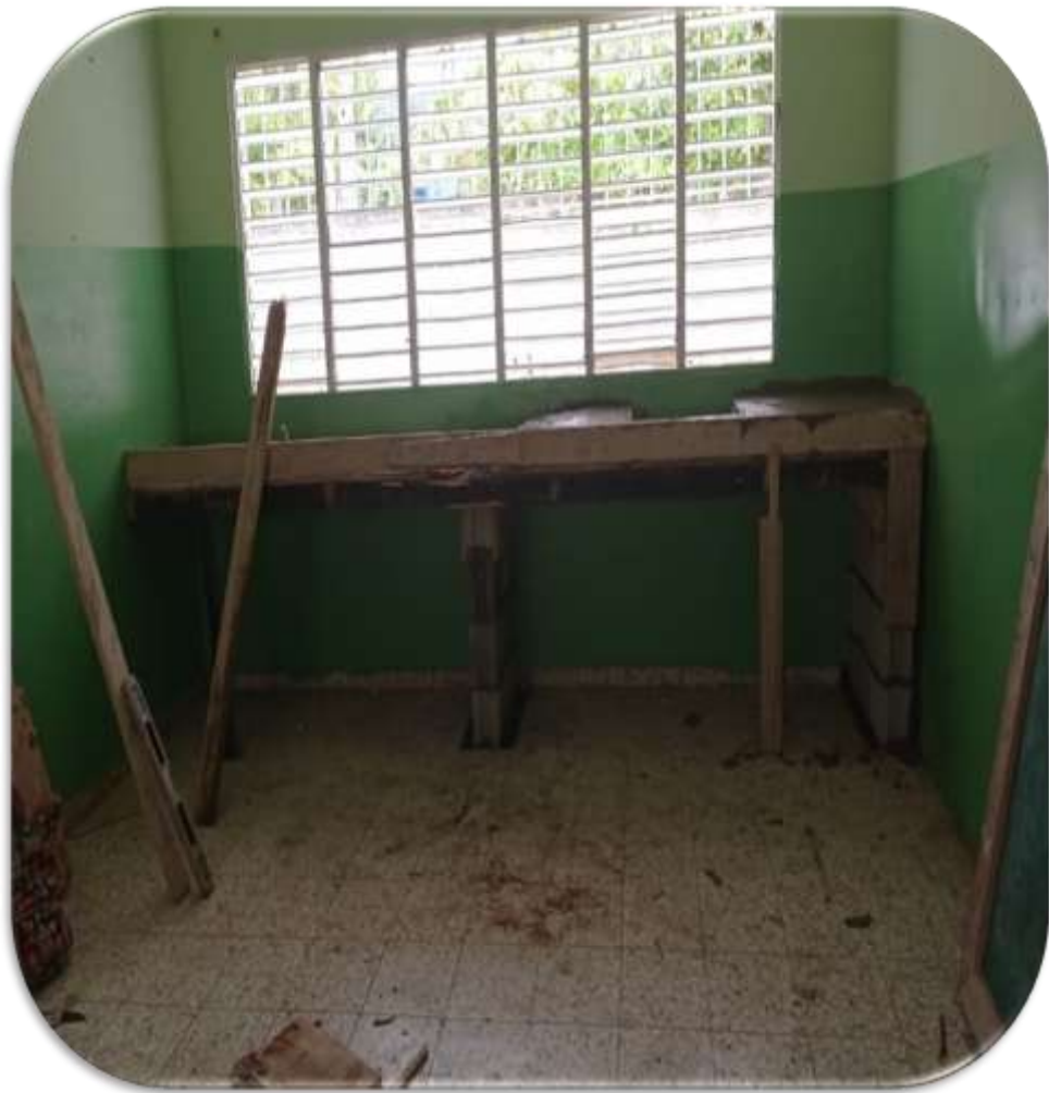
Construcción de la meseta
