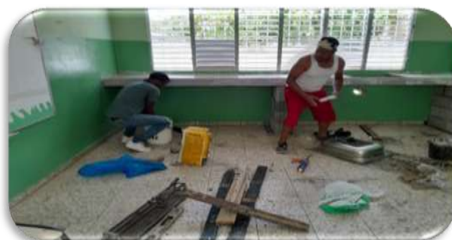
Instalación del fregadero
