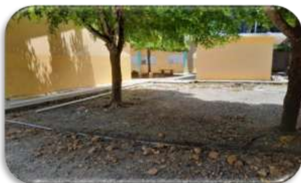
Instalación de plomería
