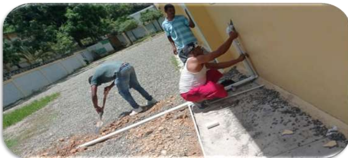
Instalación de plomería del laboratorio
