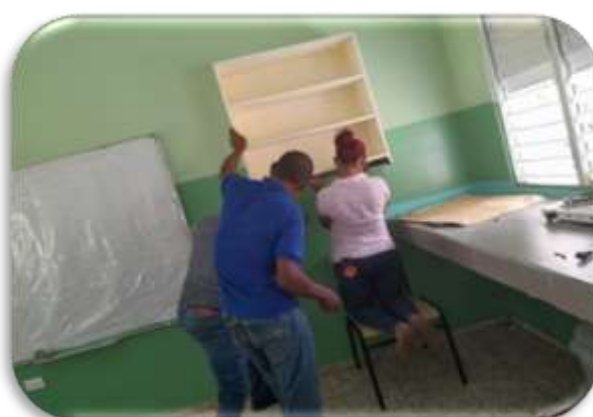
Colocación del estante
