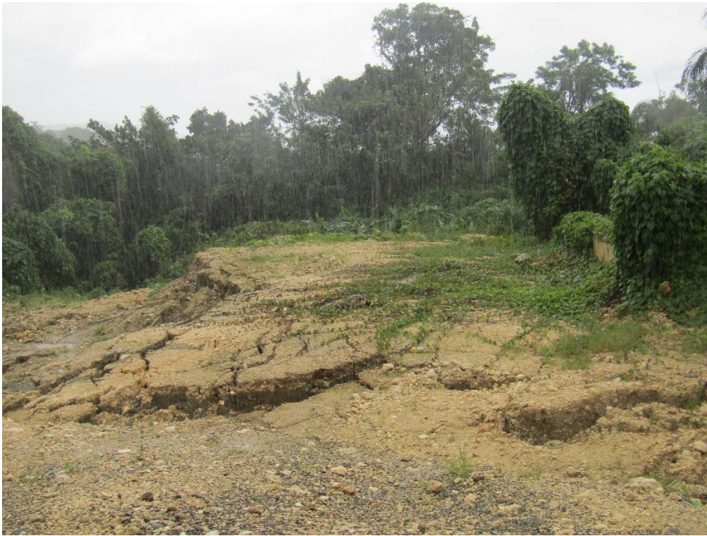
Fig.6. Material movilizada Carretera San Víctor - Amaceyes Arriba
