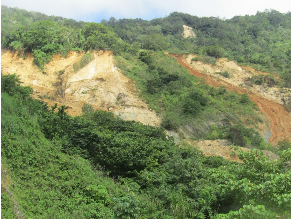
Fig.8. Deslizamiento Carlos Díaz
