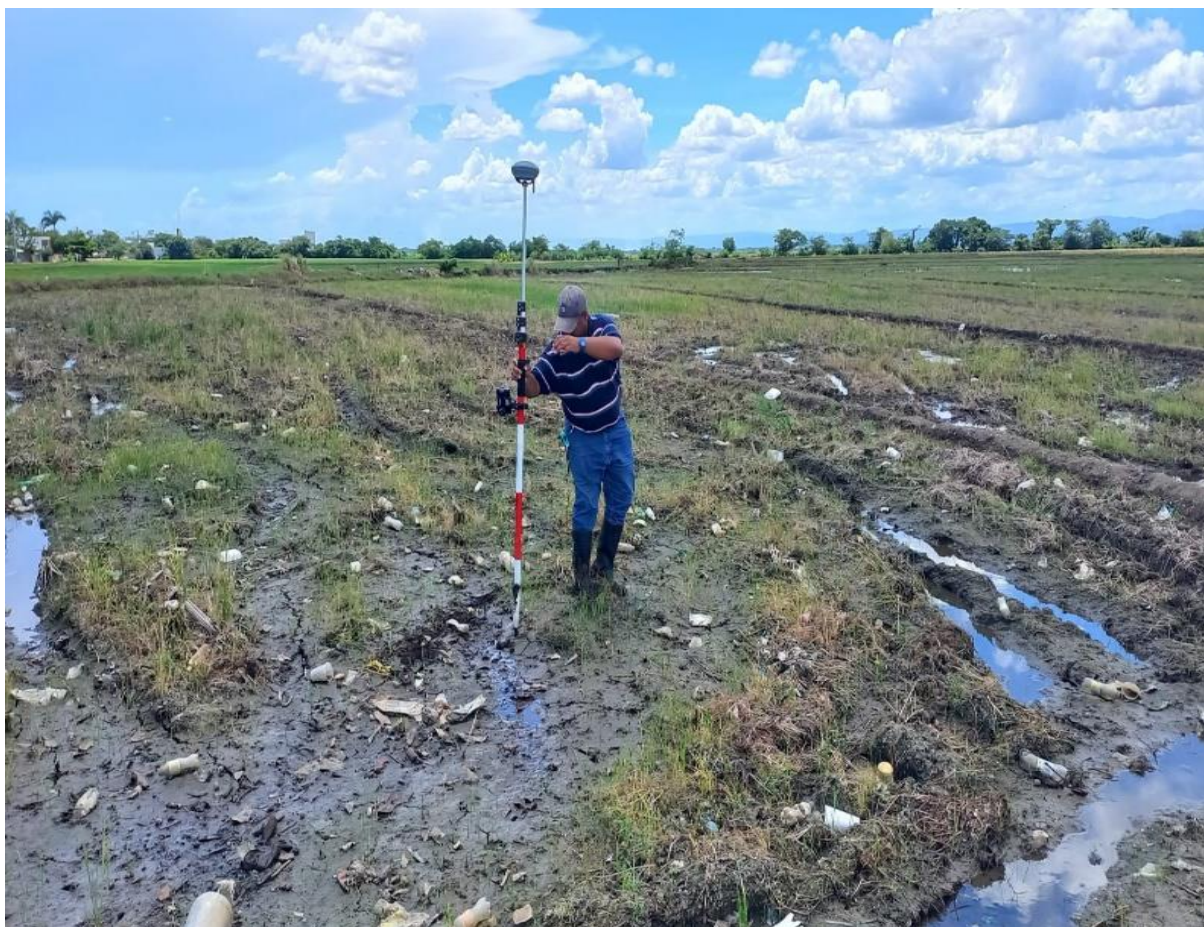
Gráfico No. 30. Agrimensor realizando el levantamiento topográfico de la zona para la ubicación del humedal artificial. Fuente: Elaborado por el equipo investigador.
